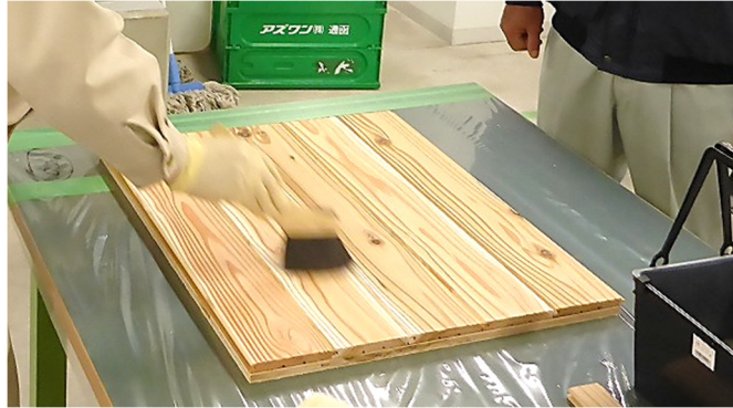
写真 5 型枠の清掃の様子
